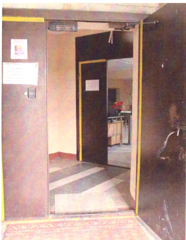
Фото № 9 дверь (входная)
