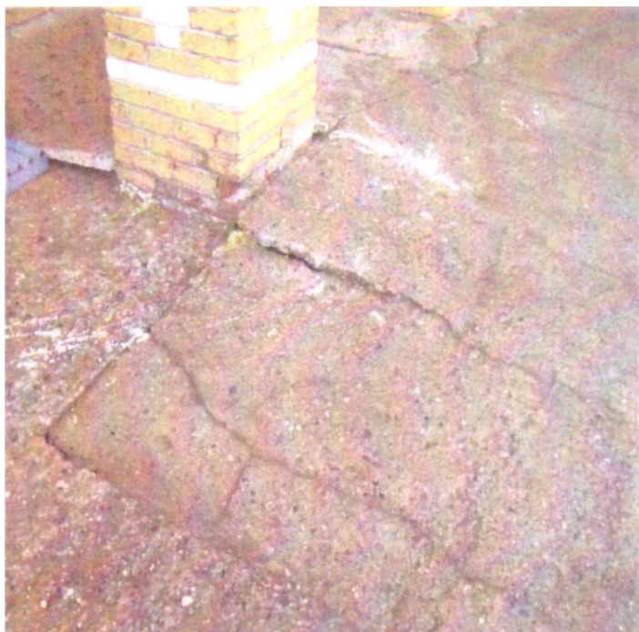
Фото № 7 входная площадка
