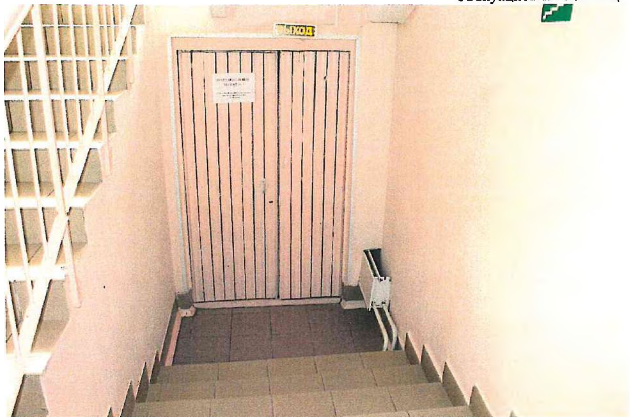
Фото № 29 Эвакуационная лестница
