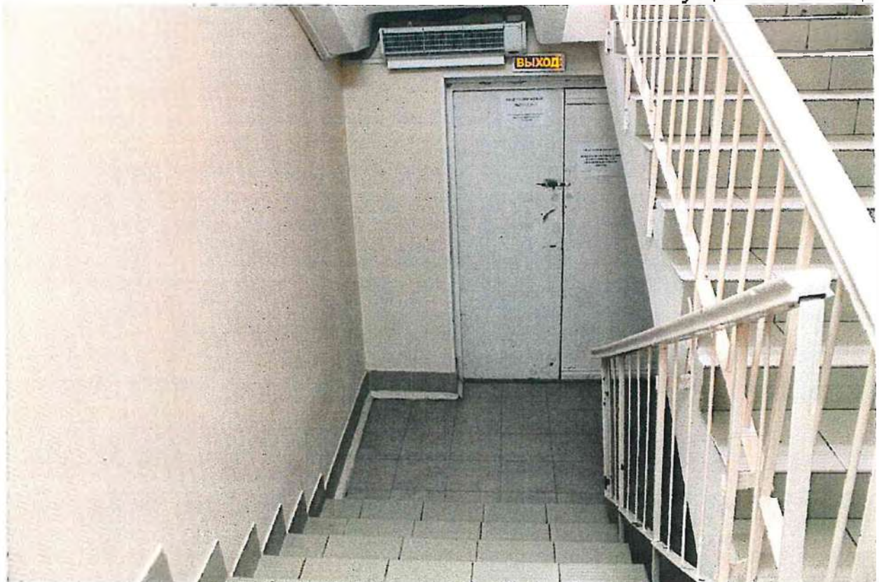
Фото № 28 Эвакуационная лестница
