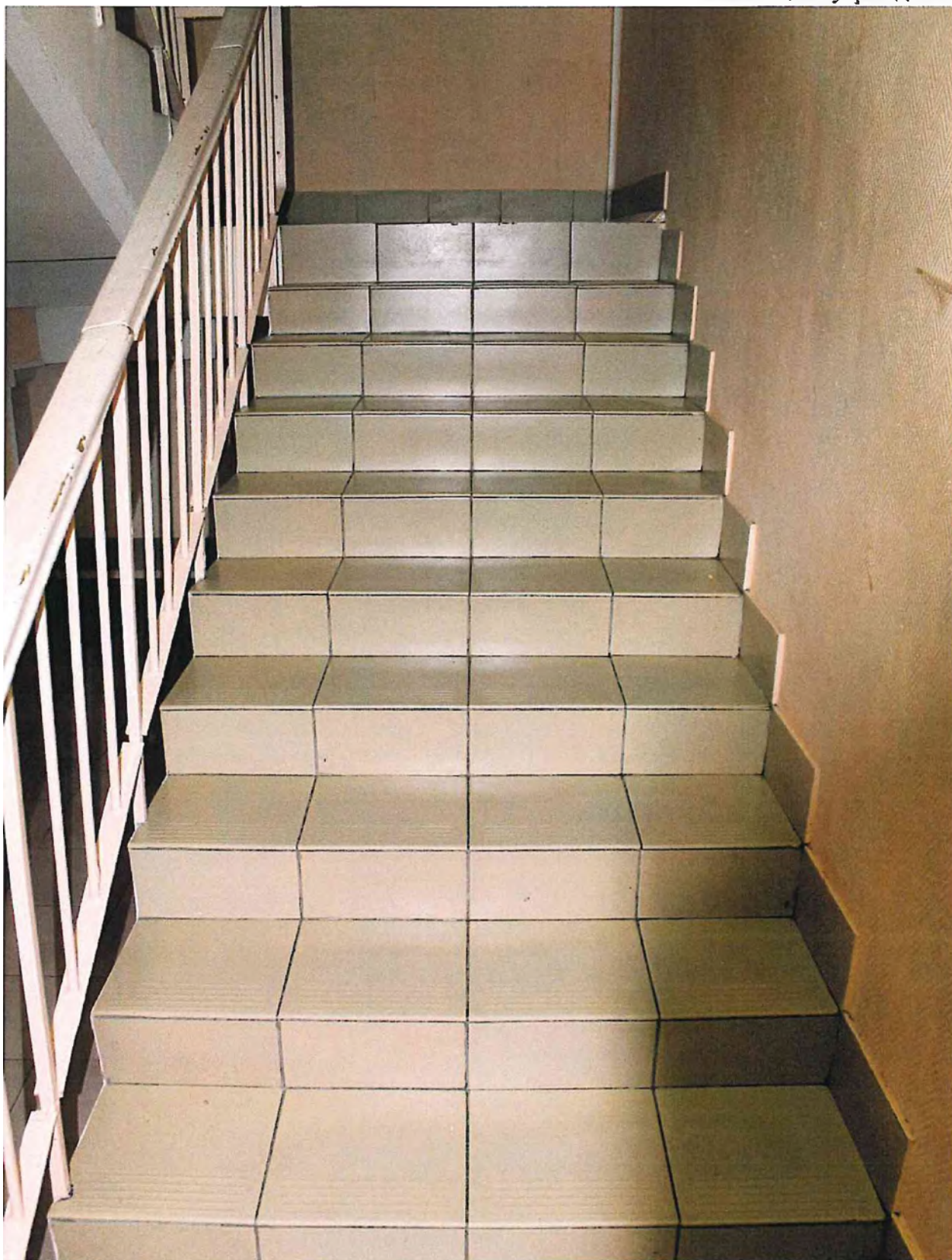
Фото № 17а Лестница внутри здания
