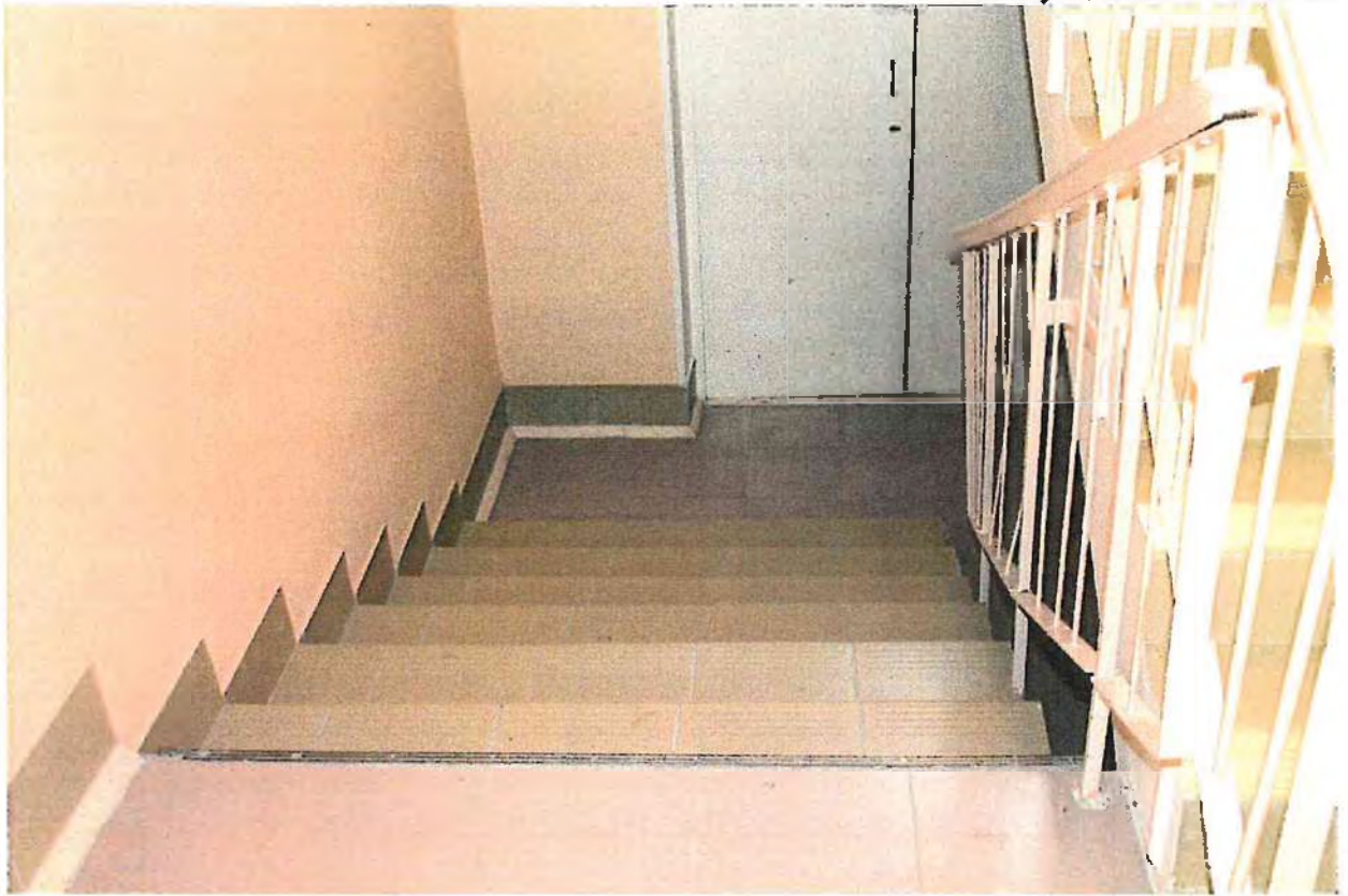
Фото № 27 Эвакуационная лестница
